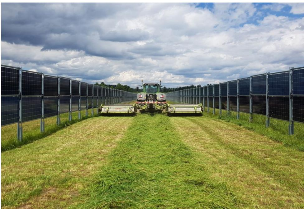
**Figura 3:** Sistema AgriPV comercial con módulos bifaciales y en disposición vertical de 4,1 MWp de la empresa Next2Sun GmbH en Donaueschingen, Alemania, combinado con la producción de heno (Enkhardt et al., 2020).
