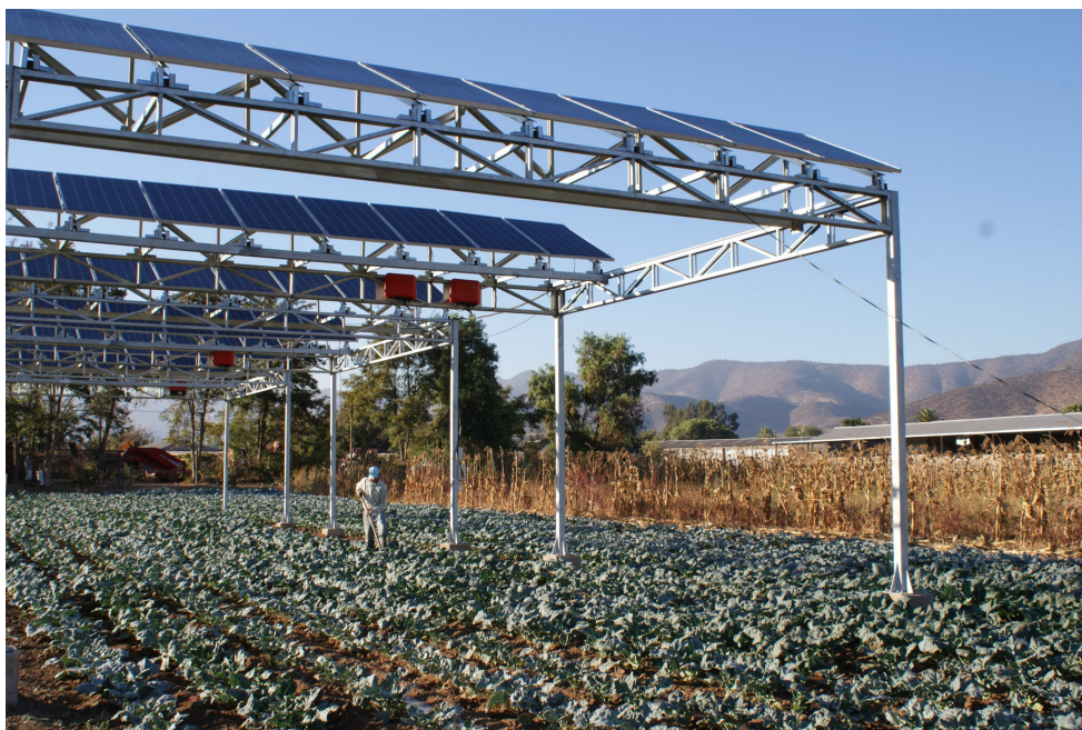
Figura 2: Sistema AgriPV con módulos monofaciales y altura libre desarrollado en el proyecto FIC-R 2015 CÓDIGO BIP 30449383-0 por Fraunhofer Chile Research. En el proyecto, financiado por el Gobierno Regional Metropolitano de Santiago, se implementaron tres proyectos piloto en colaboración con agricultores del sector de la horticultura en Lampa, Curacaví y El Monte (Fraunhofer Chile Research, 2018).
