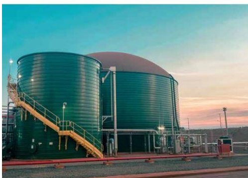
Biodigestores como parte de la planta de producción de pectina de la empresa Cargill
