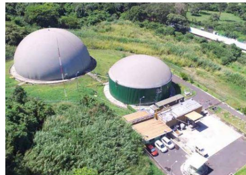
Biodigestor CIISA (El Arreo) – Fermentador con tanque de almacenamiento de gas externo
